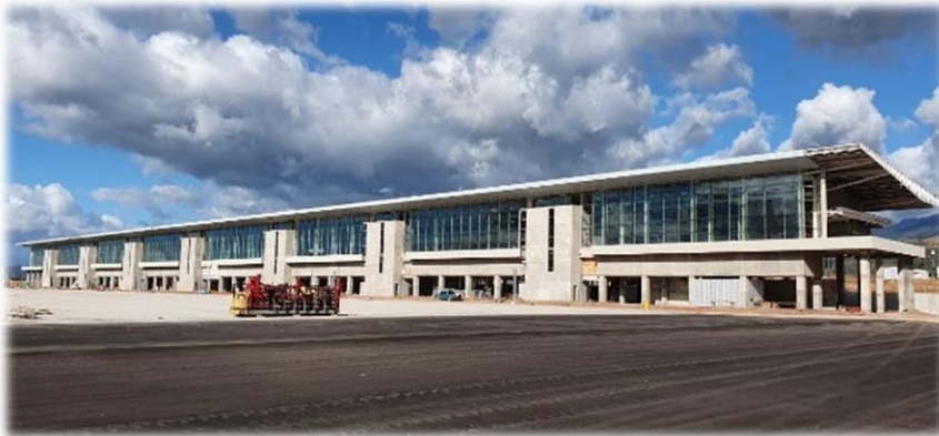
AVANCE DE OBRAS EN AEROPUERTO PALMEROLA
