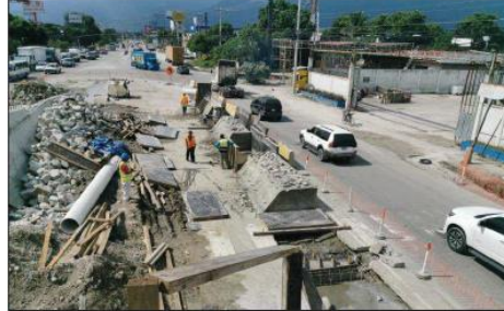
Construcción de muro de retención Sur, lado izquierdo.
