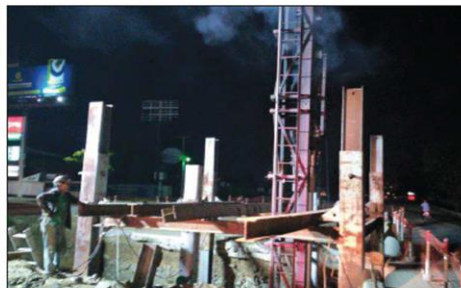
Hincado de pilotes en zapatas de Pilastra #1
