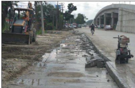
Preparación de ramal 27 calle – SPS para pavimentación
