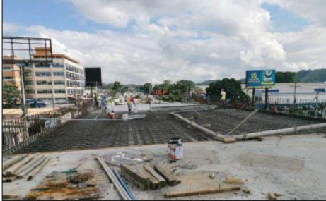
Colado de concreto en claro #4 de puente.
