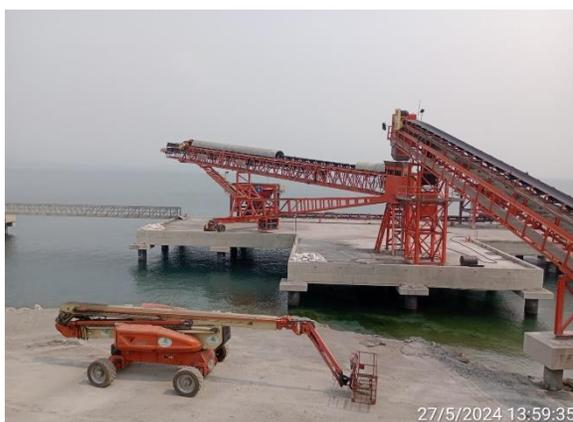
Se observa una grúa con canasta para realizar mantenimientos en todo el sistema de bandas mecánicas.
