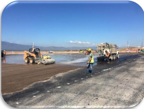
Barrido y lavado de la arena secante de la imprimación de la plataforma de aeronaves.
