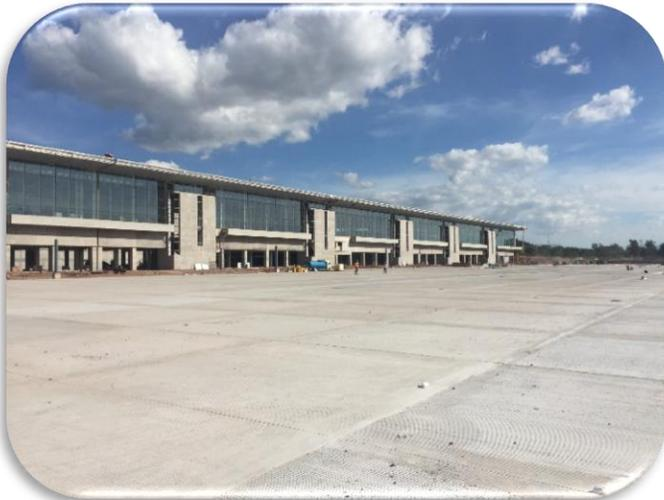
Area en donde se realizó la prueba de punto de riego de la imprimación para la base, se utilizaron puntos de 0.20, 0.28 y 0.30.
