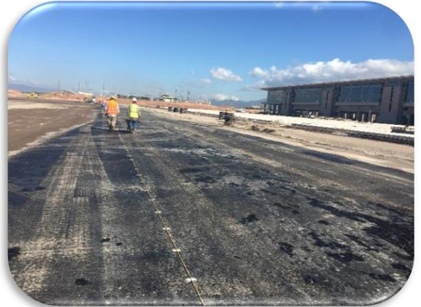
Área lista para colocar la primera capa de la carpeta asfáltica de 5.00 cm de espesor con un ancho de trocha de 6.00 ml de ancho.
