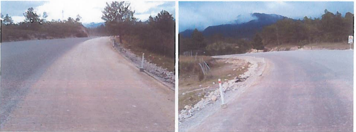
Vista de un sector donde se inició la colocación de Doble Tratamiento Superficial.
