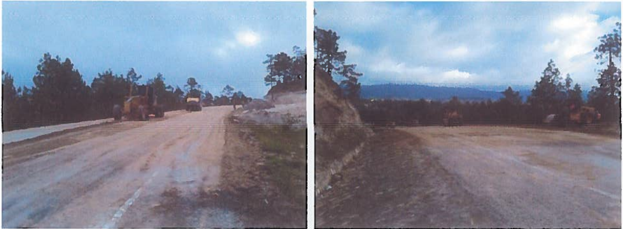
Vista de los trabajos de terracería en un sector intervenido.
