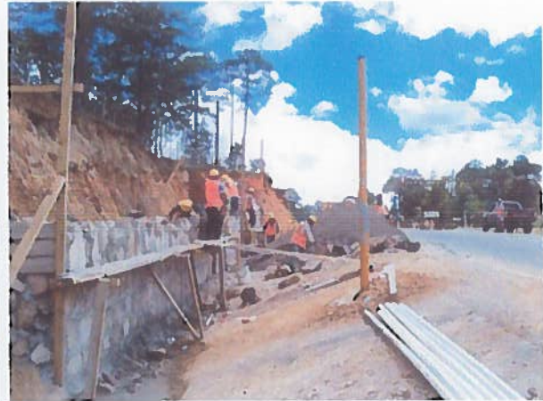
Vista de los trabajos de construcción de muro de mampostería en el tramo Desvío de Yamaranguila - El Obispo.
