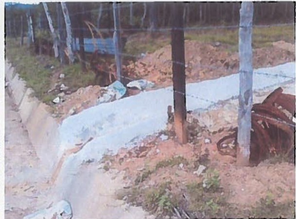
Vista de la cuneta revestida construida para encauzar el agua hacia la contracuneta de las estaciones 6+300 a 6+350, LD.
