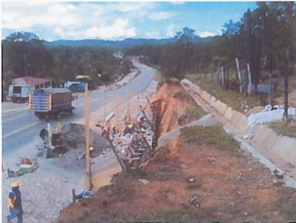
Vista de los trabajos de construcción de muro de mampostería en el tramo Desvío de Yamaranguila - El Obispo.
