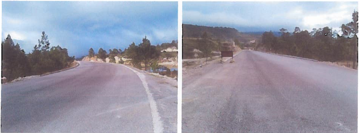
Vista de uno de los sectores donde ya se terminó de colocar el Doble Tratamiento Superficial, pero falta la colocación de vialitas y líneas con pintura termoplástica.
