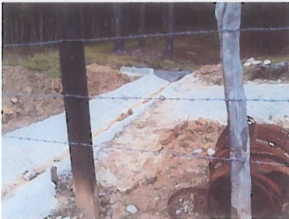
Vista de la cuneta revestida construida para encauzar el agua hacia la contracuneta de las estaciones 6+300 a 6+350, LD.
