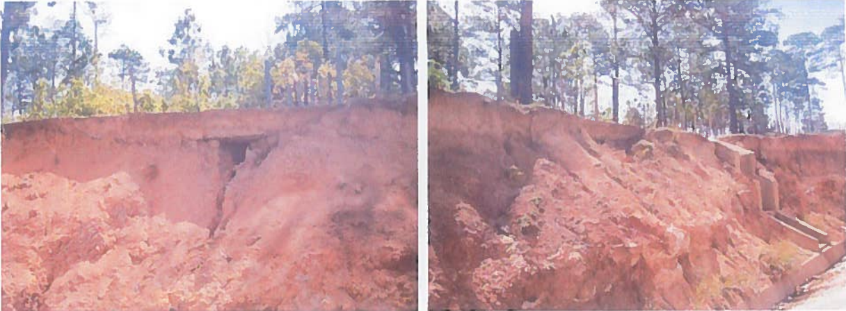
Vista de la condición original del talud donde se observa la contracuneta desprotegida.
