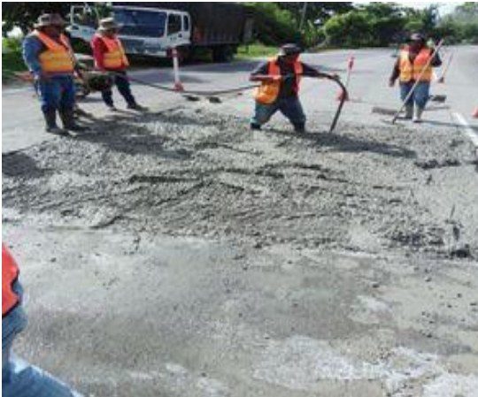
Vista de reparación de losas fracturadas o con baches.
