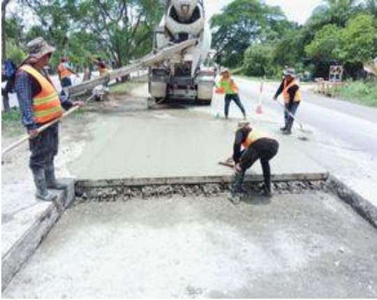
Vista de reparación de losas fracturadas o con baches.
