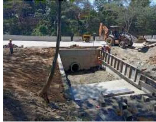
Encofrado de muro de descargas, en rampa principal.
