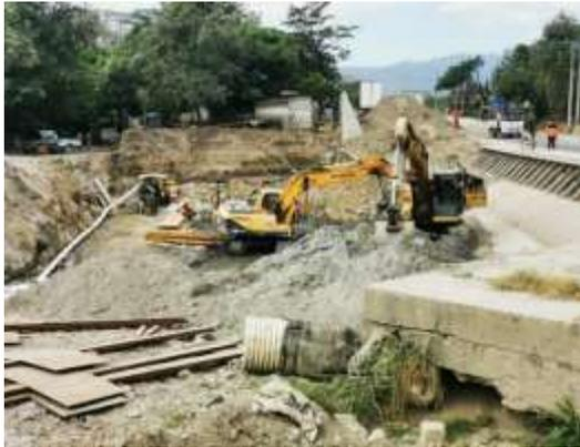
Preparación de la plataforma para hincado de pilotes, estribo Sur ala derecha.
