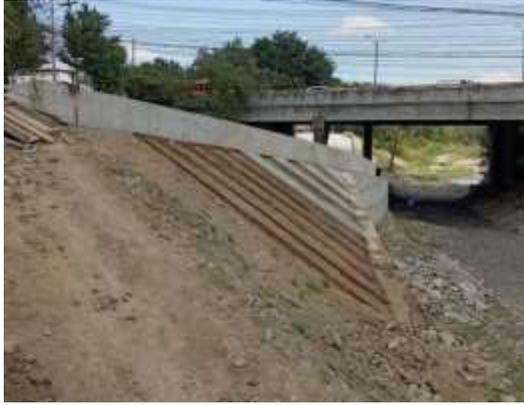
Revestimiento de talud en lado derecho de rampa principal.
