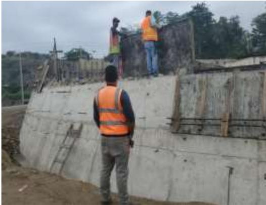
Encofrado de levante de muro de contención de concreto ciclópeo.
