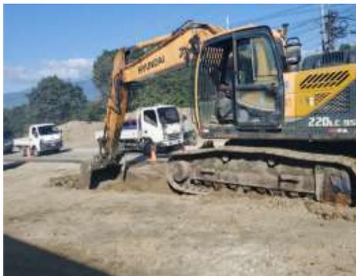
Excavación para muro de gaviones, entre Est. 0+365 y 0+375.
