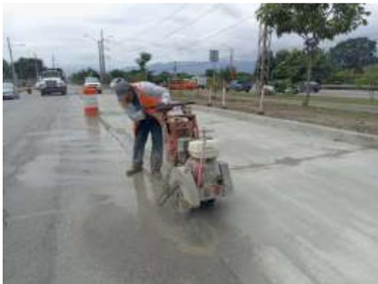
Corte para sellado de juntas en ampliación tercer carril Sur.
