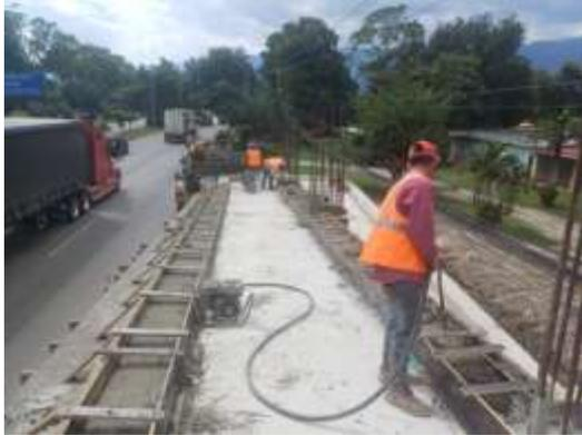
Colado de concreto en bordillos de rampa#2, Oeste.
