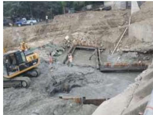
Preparación de la plataforma para hincado de pilotes, estribo Sur ala derecha.
