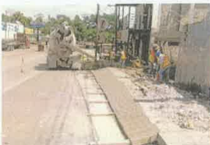
Foto 7. Vista de la acera construida.
