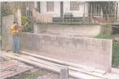
Foto 4. Vista lateral de la pared que colinda con una quebrada.
