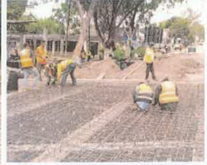
Foto 3. Vista del trabajo ejecutado, lado derecho.
