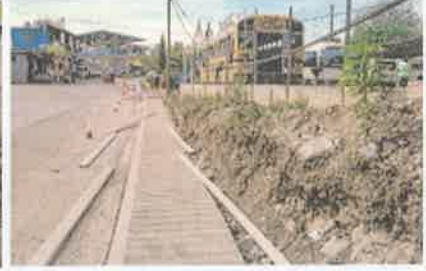
Foto 3. Vista de la acera peatonal construida.
