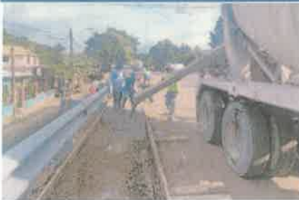
Foto 1. Fundición con concreto hidráulico de acera peatonal.
