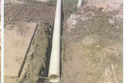
Foto 6. Colocación de tubería de PVC de 6 pulgadas.
