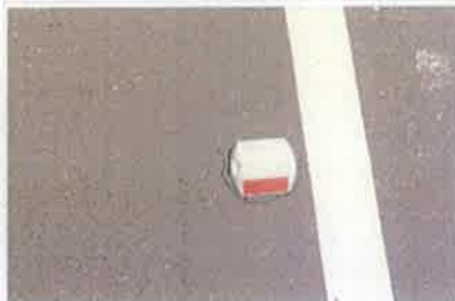
Foto 5. Colocación de vialetas doble cara sobre el pavimento.
