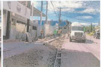
Foto 6. Fundición con concreto hidráulico de acera peatonal.
