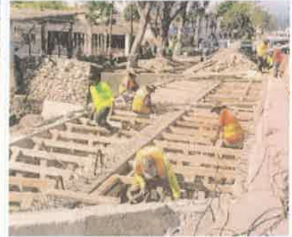
Foto 3. Vista del trabajo de encofrado realizado, lado derecho.
