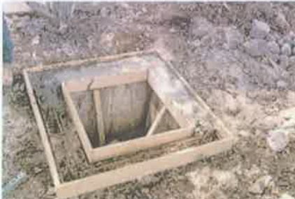
Foto 4. Fundición parte superior de caja de registro.
