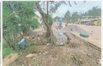
Foto 9. Construcción de Gavión.
