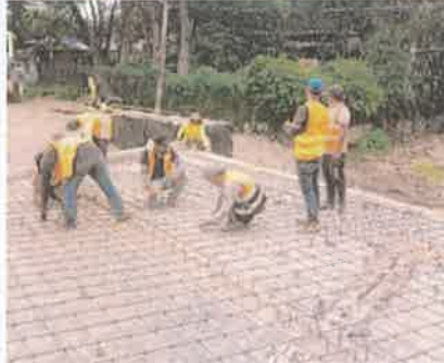
Foto 2. Vista de los trabajos realizados
