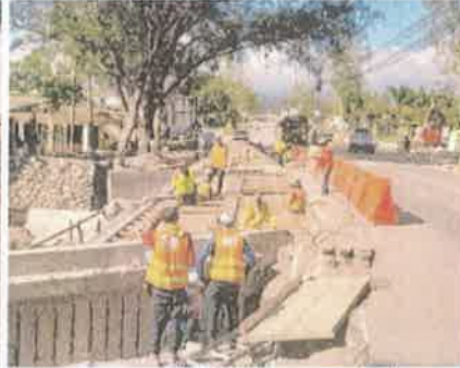
Foto 2. Vista del trabajo de encofrado realizado
