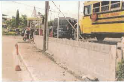
Foto 2. Vista del segmento de pared construida.
