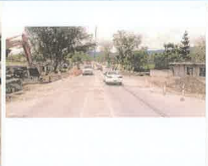
Foto 3. Vista frontal de la construcción del Puente.
