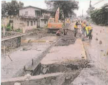
Foto 1. Demolición de acera peatonal y resto de pretil.
