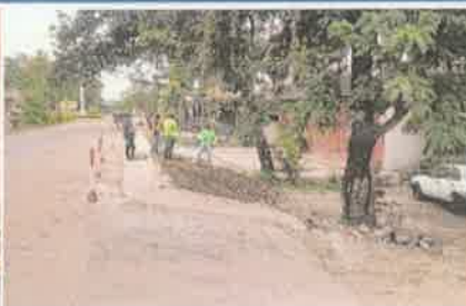
Foto 2. Vista de las áreas en donde se construyó acera peatonal
