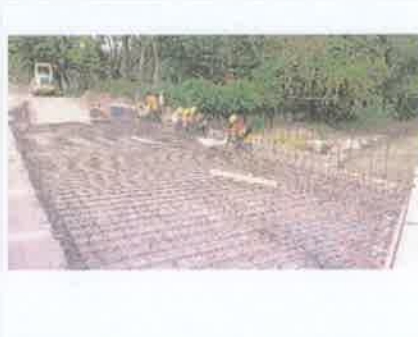
Foto 5. Vista del armado con acero de refuerzo (losa)
