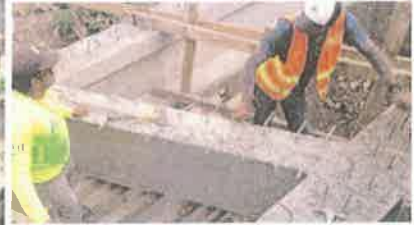
Foto 3. Diafragma construido entre vigas.
