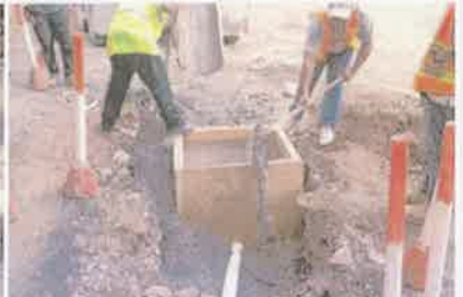
Foto 6. Construcción caja de registro
