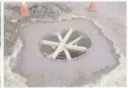
Foto 9. Fundición casquete de caja de registro.
