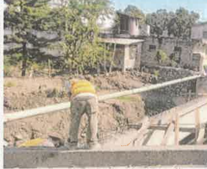
Foto 2. Reubicación de tubería metálica en el Puente.
