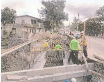
Foto 1. Construcción de diafragmas entre vigas pretensadas.
