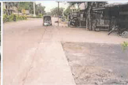
Foto 3. Vista de la acera peatonal construida.
