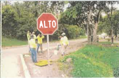
Foto 2. Instalación de la señalización vertical.
