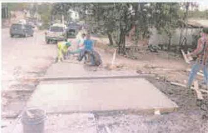
Foto 4. Construcción de acera peatonal y acceso
