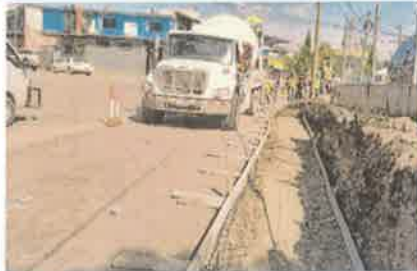
Foto 1. Fundición con concreto hidráulico de acera peatonal.
