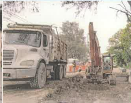
Foto 2. Retiro de material sobrante de excavaciones.
