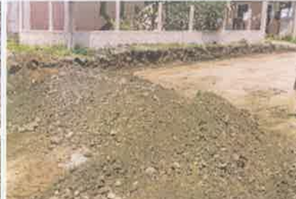
Foto 5. Trabajos de terracería realizados en acceso a calle.
