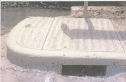
Foto 5. Vista del tramo de acera peatonal construido.
