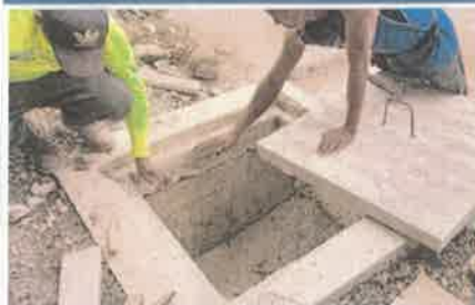
Foto 1. Construcción caja de registro
