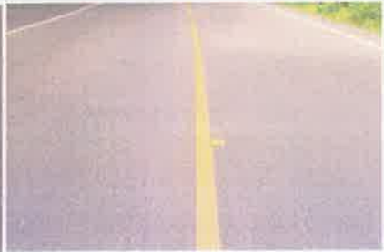
Foto 6. Colocación de vialetas doble cara sobre el pavimento.
