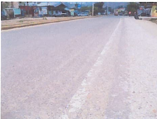
Vista de la condición original, en la inspección anterior.
