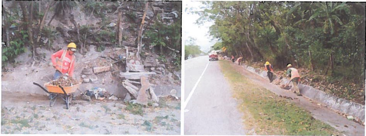
Personal del Contratista realizando limpieza de cunetas y recolección de basura.
