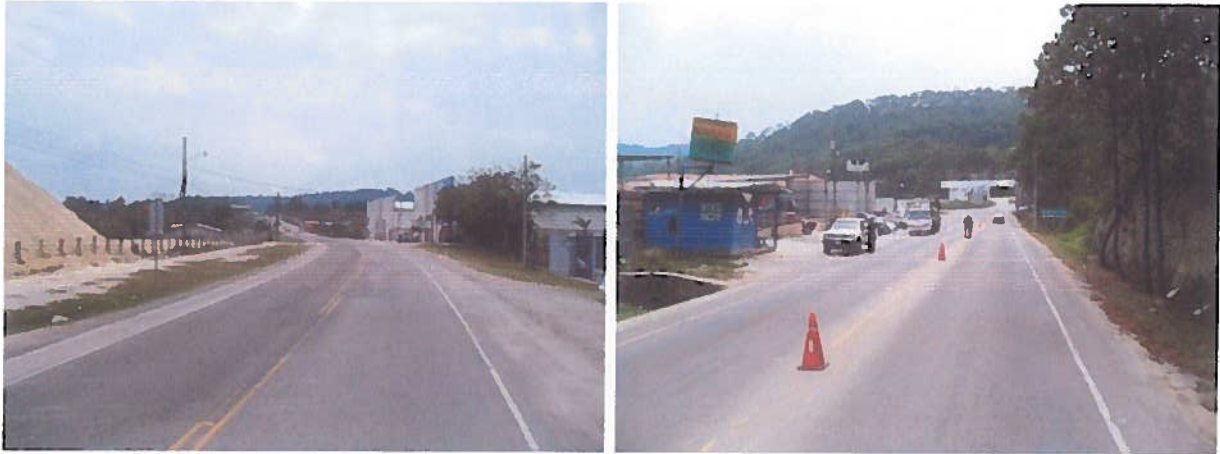
Vista de los sellos superficiales colocados en los 2 últimos kilómetros del tramo, según requerimientos de la SAPP.
