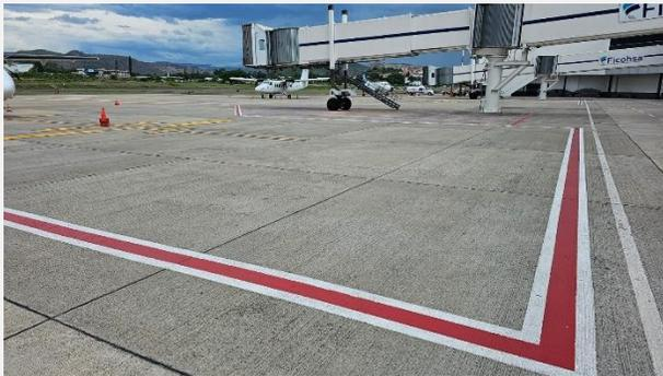
El Concesionario realizo trabajos de demarcación de señalización horizontal. Específicamente los puestos de estacionamiento de aeronaves y radios de giro.
