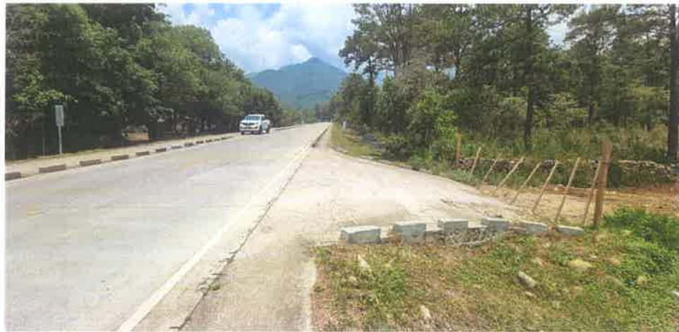
Imagen del Acceso Lateral con Pavimento en el Km 4+000 L. D, como se puede ver aun se mantiene el acceso en buen estado.
