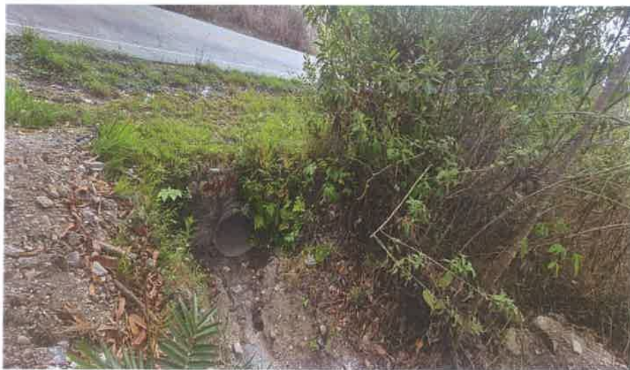
Toma en la entrada de la Alcantarilla Transversal del Km 74+180, se puede observar que su canal de salida en condiciones de drenaje aceptables.
