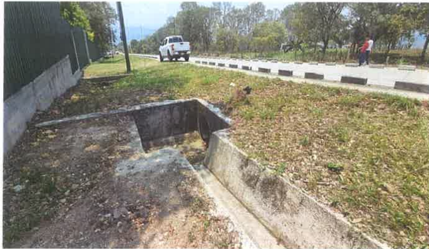
Toma en la entrada de la Alcantarilla Transversal en el Km 2+965. Observese que esta libre de materiales.
