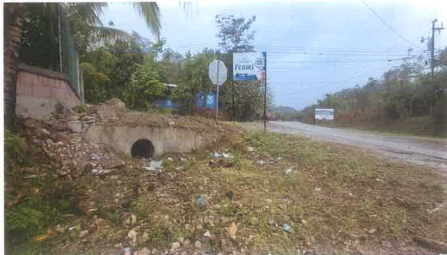
Toma en el Acceso Lateral del km 81+180 L. I., se puede observar que tanto su salida y su interior están limpios.
