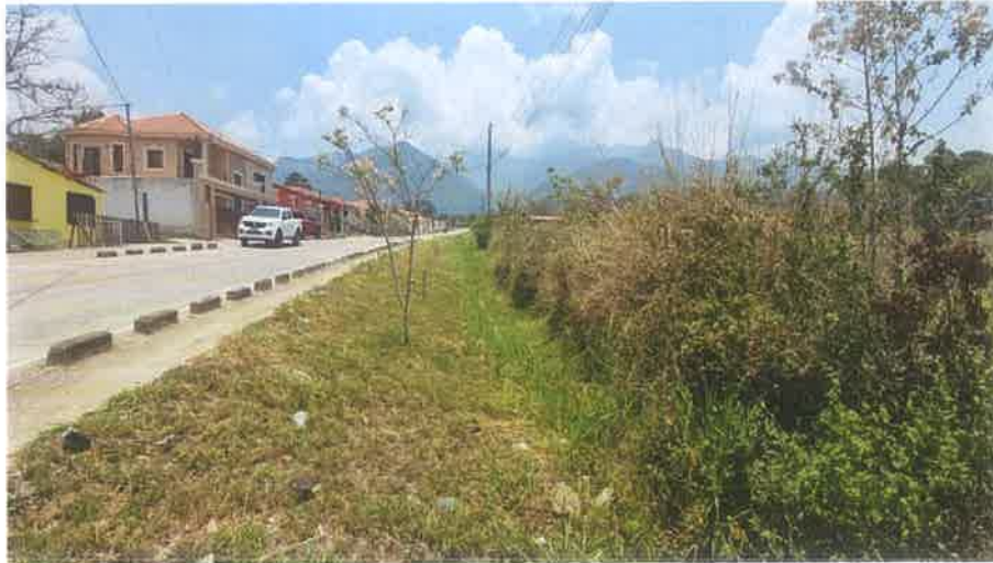
Imagen en el Derecho de Via del Km 3+061 L. D. donde se puede observar que se mantiene limpio y sin maleza fuera de Especificaciones
