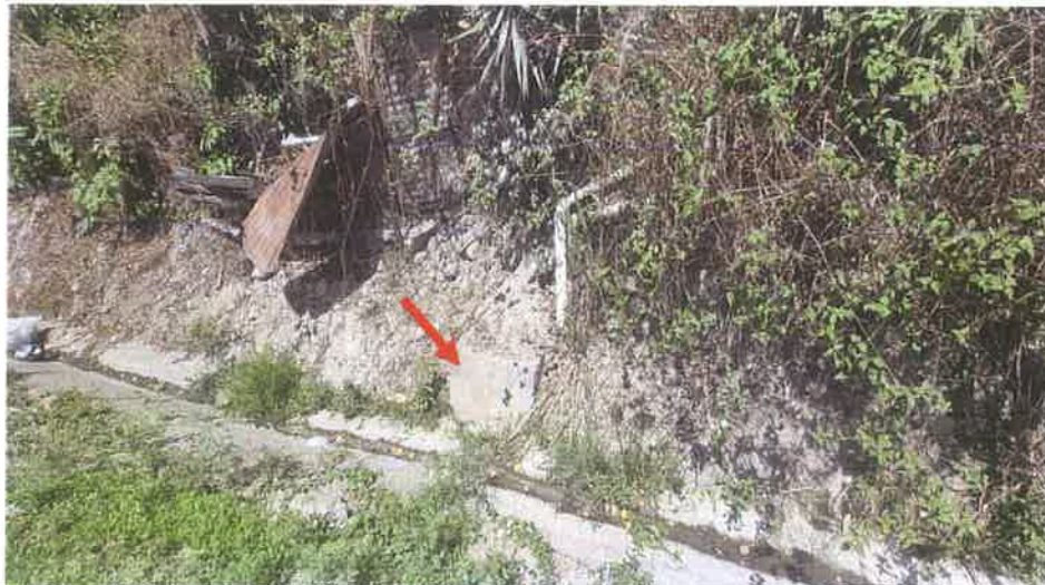
Pozo de Inspección construido en el Km 48+418 donde se puede observar que aun se mantiene en buen estado y sin problemas.
