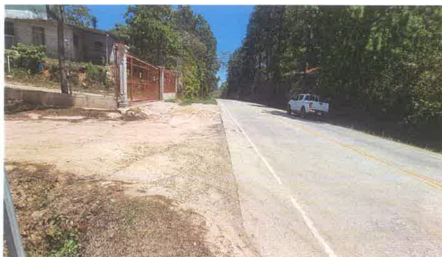
Acceso Lateral con pavimento en el Km 51+925 L. I., se puede ver que se mantiene en buen estado y sin hacer grada en el hombro.
