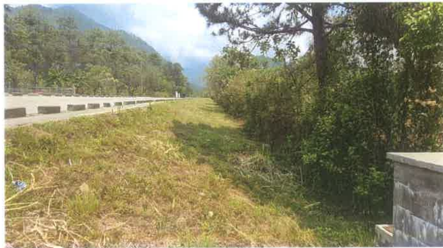
Toma de la Cuneta sin Enchape del Km 4+935 L. D. Se puede observar que esta limpia y sin erosiones.
