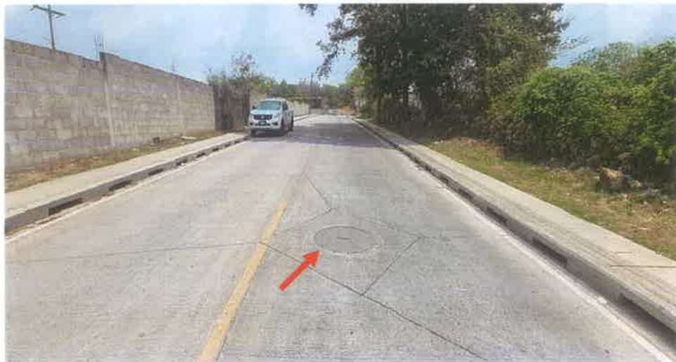
Toma de la Tapadera en el Pozo de Inspeccion en el Km 0+425. Se puede ver que esta en buen estado.
