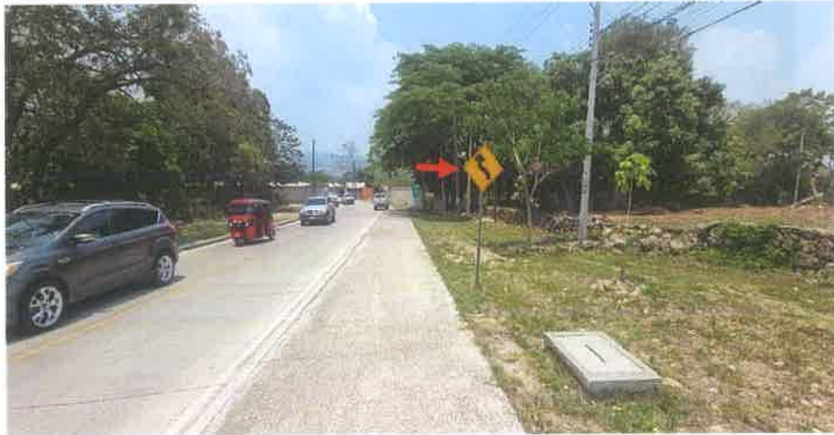
Toma de la Señal Vertical del Km 1+225 L. I., donde se puede ver que la señal instalada aun se mantiene en buen estado y a plomo.
