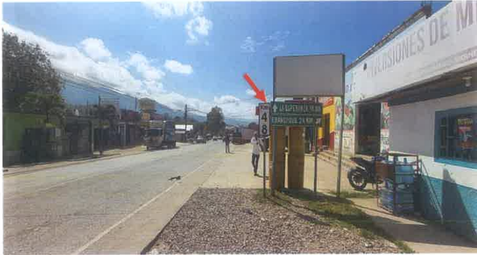
Toma de la Señal Vertical instalada en el Km 48+000 L. I., observese que aun se mantiene en buen estado y a plomo.
