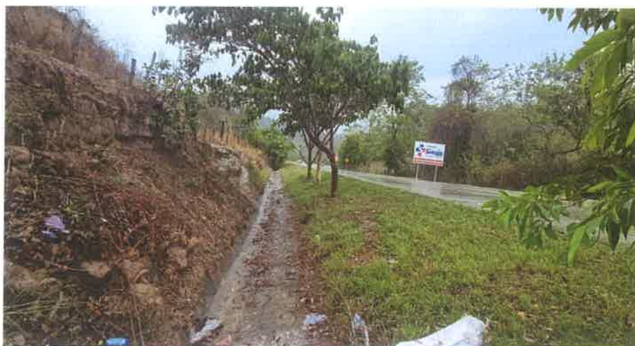
Toma de la Cuneta Enchapada en el Km 81+413 L. I., donde se puede observar que esta totalmente limpia y sin material azolvado.
