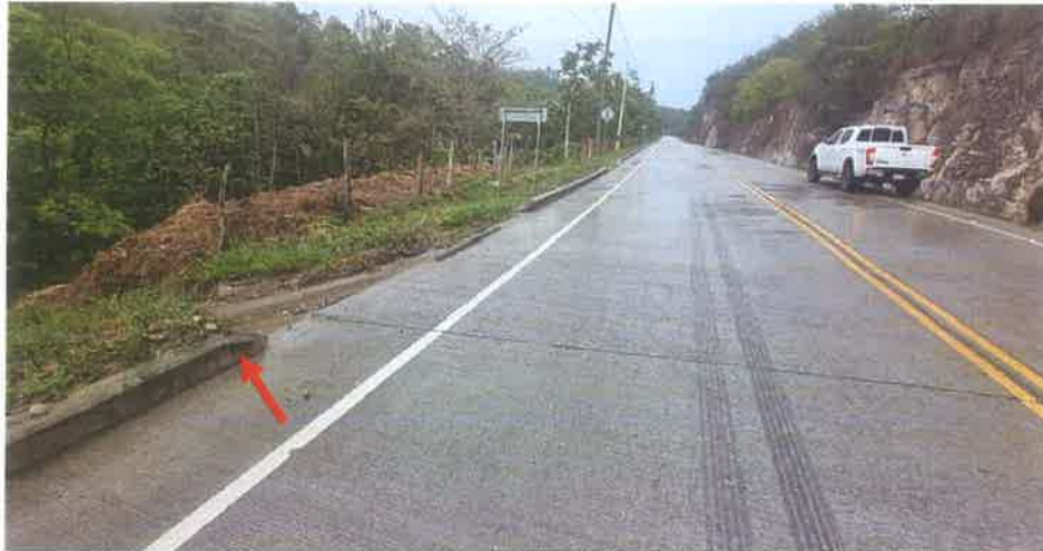
Toma del Bordillo de Carretera en el Km 77+835 L. I., se puede ver que se mantiene en buen estado y libre de materiales en su costado.
