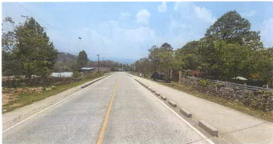
Toma de la Calzada de Rodadura del Km 2+340, se puede ver que esta totalmente limpia y sin baches.
