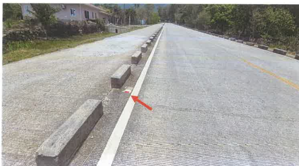
Toma en la Hombro Derecho del Km 4+080, donde se puede constatar que tanto la Pintura Termoplastica como las Violetas de ese tramo se mantienen buen estado.
