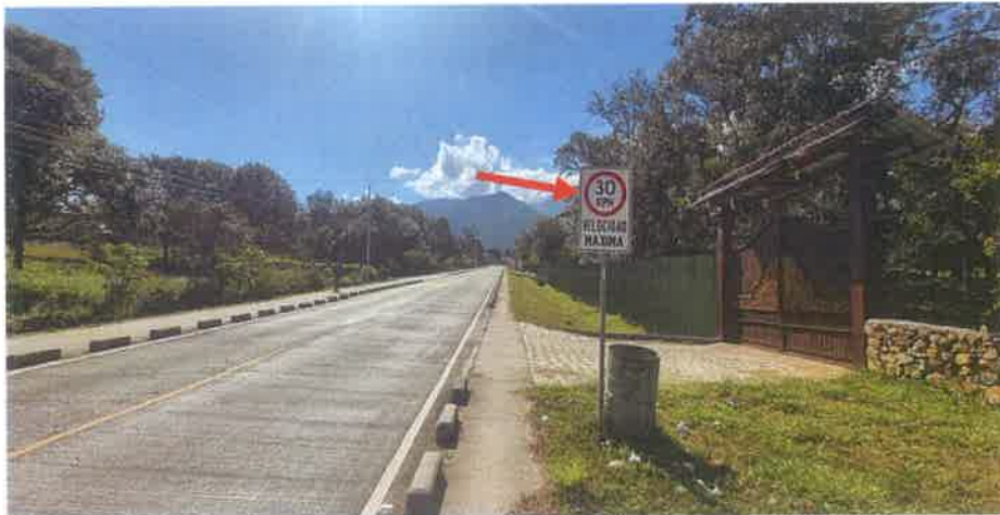
Toma de la Señal Vertical instalada en el Km 2+811 L. D., se puede ver que se mantiene en buen estado y limpia.
