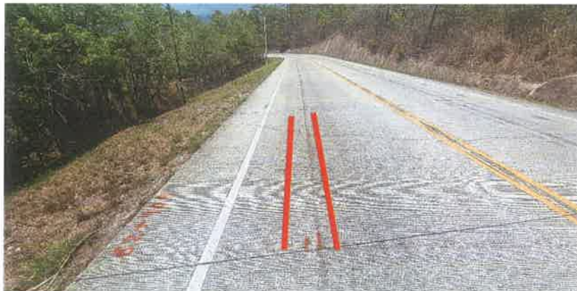
Sellar Grieta en el Km 65+187 A. L. (derecha)
