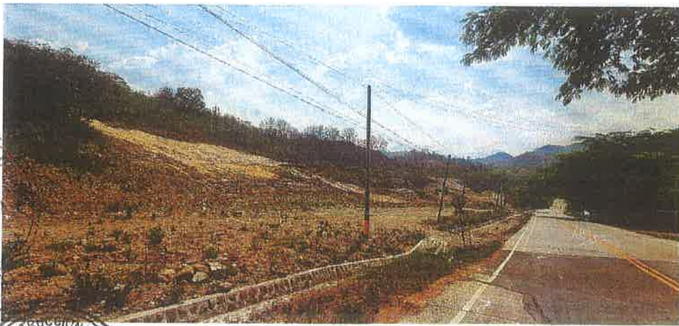
Imagen en la zona de la falla, sin ningunas actividades recientes.
