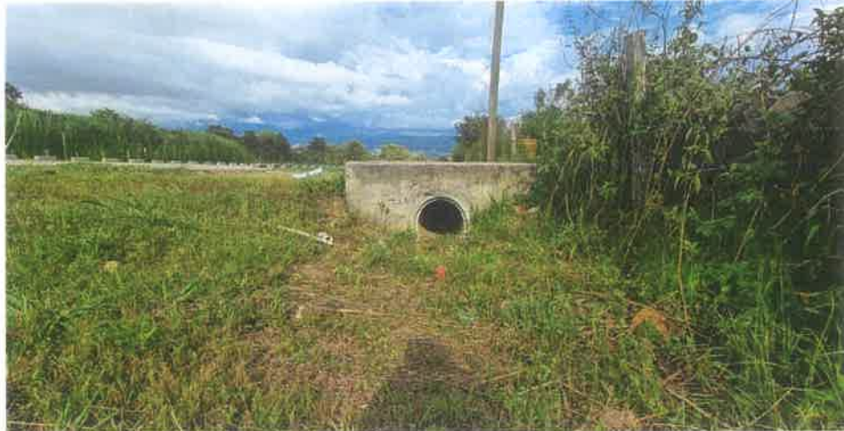
Toma del Acceso Lateral del Km 3+448 L. I. Obsérvese que tanto su salida e interior están totalmente limpios.
