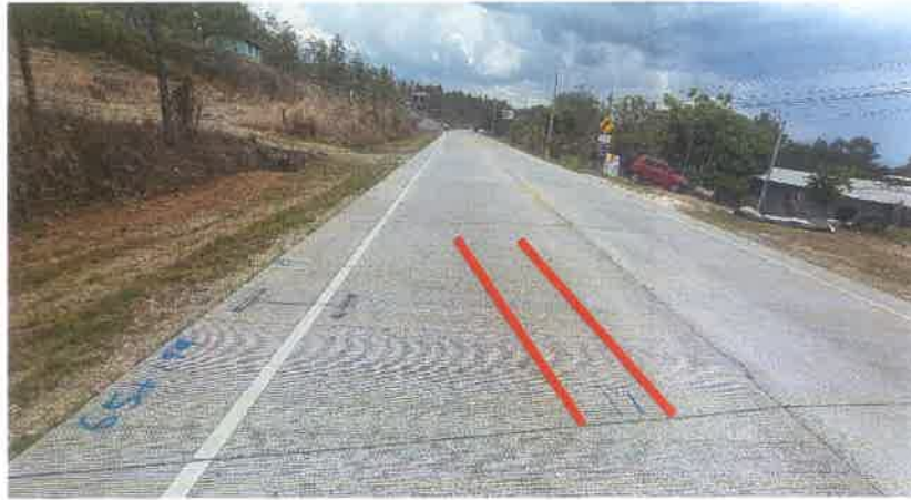
Sellar Grieta en el Km 67+437 L. I.
