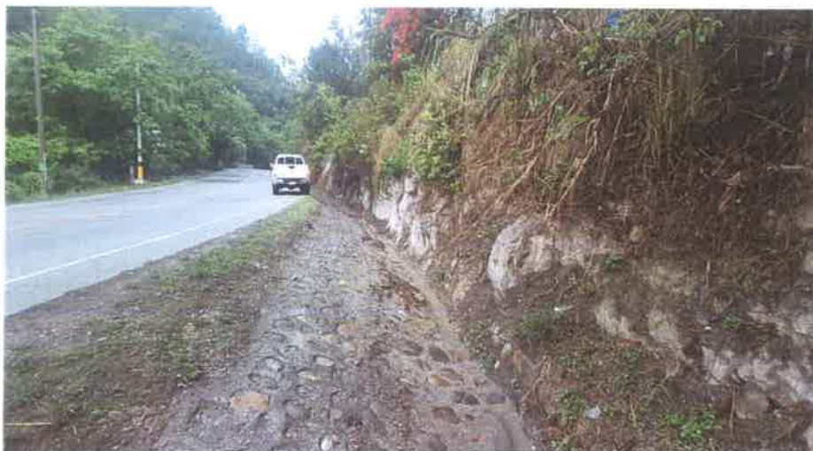
Toma de la Cuneta Enchapada del Km 79+282 L. D., se puede ver que se encuentra totalmente limpia, sin basura y sin sedimentos.
