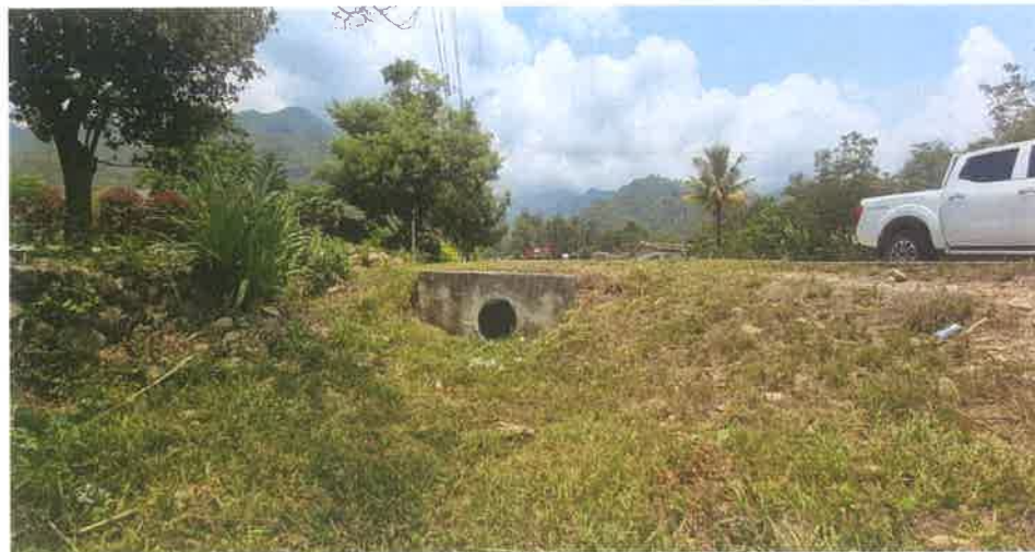
Toma del Acceso Lateral en el Km 4+674 L. I. Se puede ver que tanto su salida como su interior se mantiene limpio.
