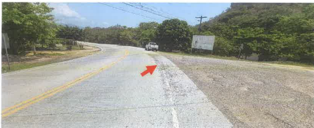
Calzada de Rodadura contaminada en Km 80+960 – 80+985 L. D.
