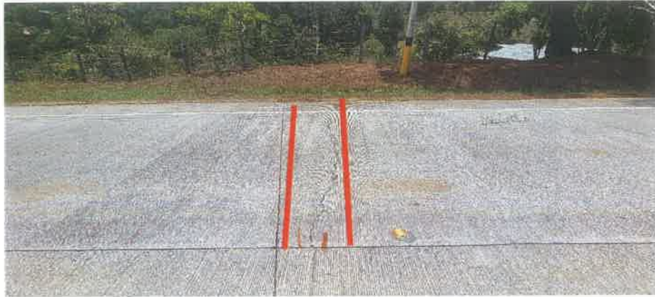
Sellar Grieta en el Km 56+241 L. I.
