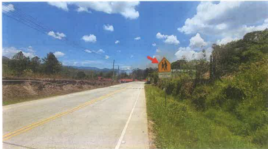
Toma de la Señal Vertical del km 58+525 L. D. donde se puede observar que se mantiene en buen estado.
