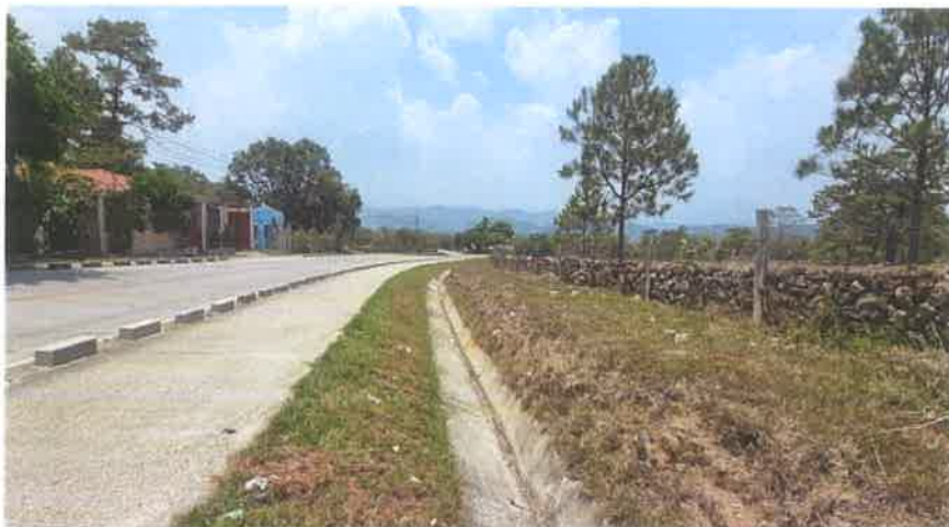
Imagen de la Cuneta Enchapada del Km 2+072 L. I. donde se puede observar que se mantiene limpia.
