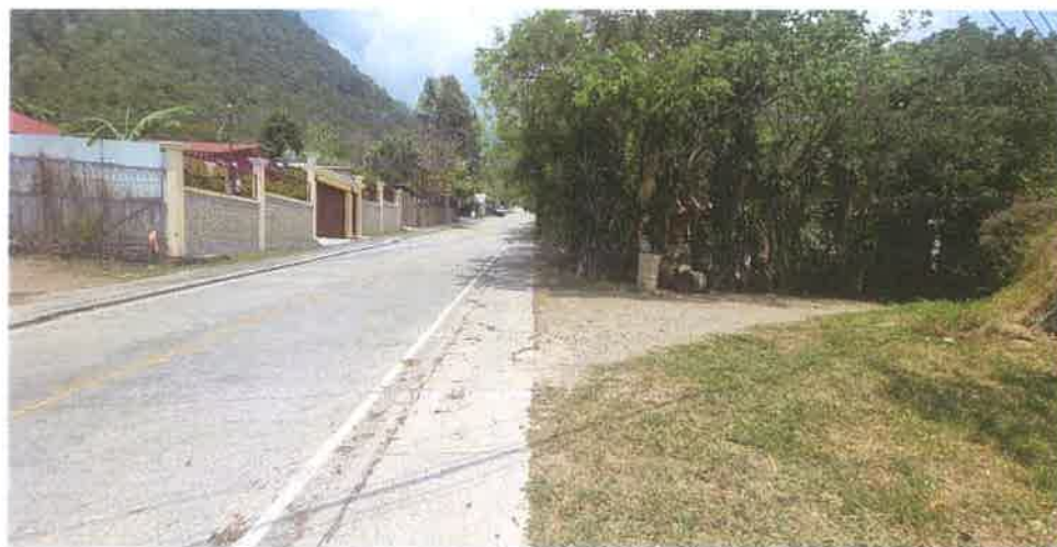
Toma del Acceso Lateral sin Pavimento en el Km 5+332 L. D., se puede ver que aun no se produce la grada entre la Acera y el relleno.
