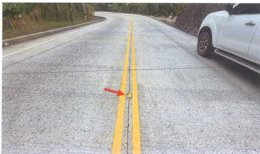
Toma en la pintura de la Linea Central y la Violeta del km 74+422 donde se puede observar que aun están en buen estado y se mantienen colocadas.
