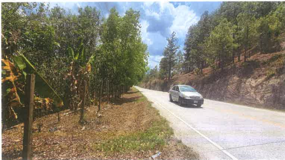
Toma del Derecho de Via del Km 61+915 L. I., se puede constatar que se mantiene la maleza dentro de los Terminos de Contrato.
