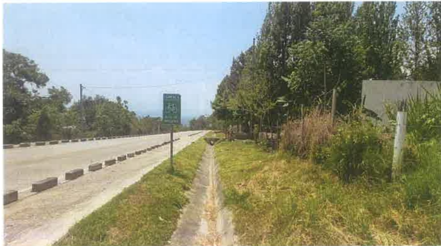
Toma en el Derecho de Via en el Km 5+305 L. I., observese que está completamente limpio y la maleza a niveles de Especificaciones
