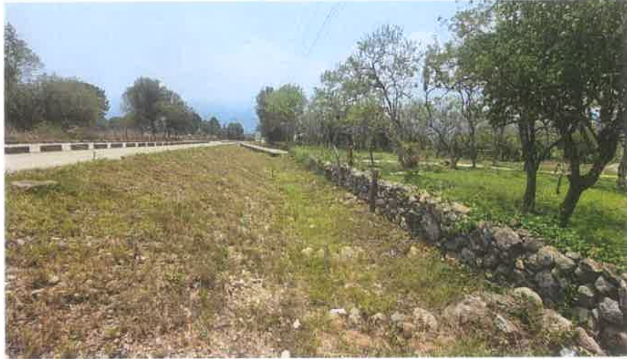
Toma de la Cuneta sin Enchape del Km 3+645 L. I., se puede ver que se mantiene sin erosiones que pongan en riesgo el terraplen.
