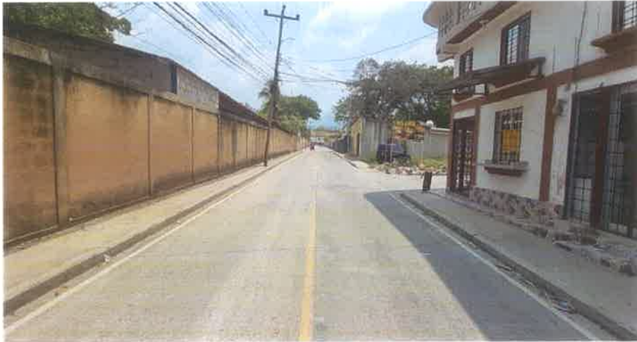
Toma de la Calzada de Rodadura del Km 0+560 donde se puede constatar que esta totalmente limpia y sin baches.
