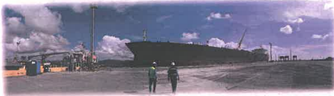
Muelle 3-B en operación.
