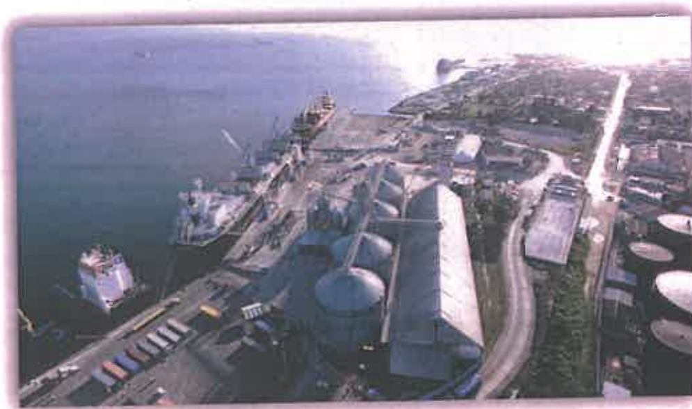
fotografía de ángulo cenital se aprecia el canal Climaco y todo el muelle finalizado.
