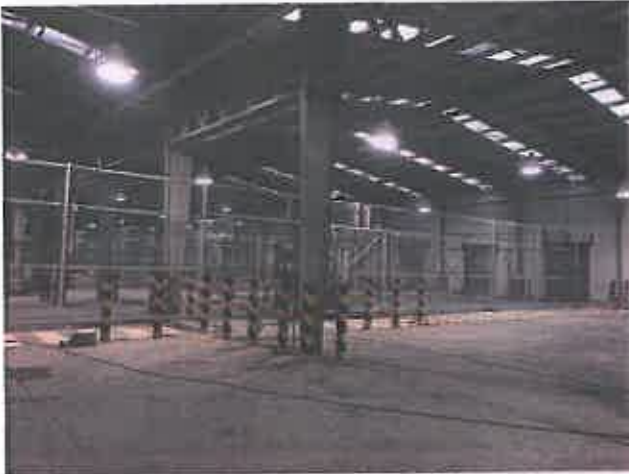
interior de Bodegas (Patio de Revisión C7)
