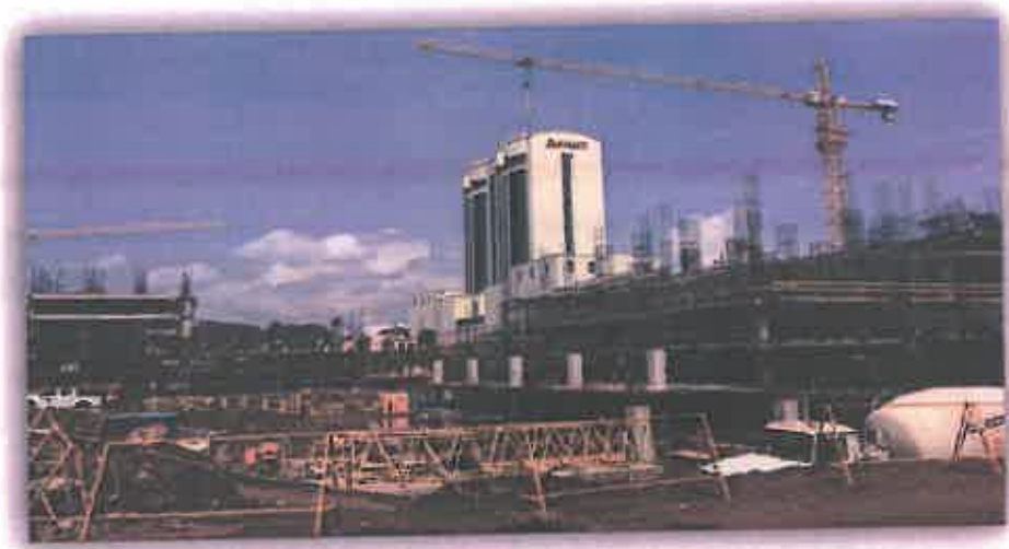
Avance de Obras
