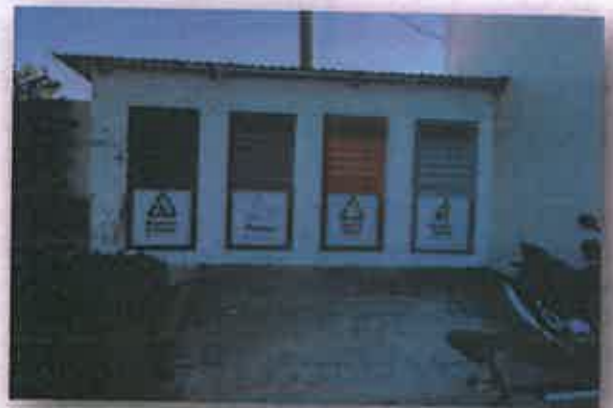
Construcción del nuevo Centro de Recolección de Desechos sólidos
