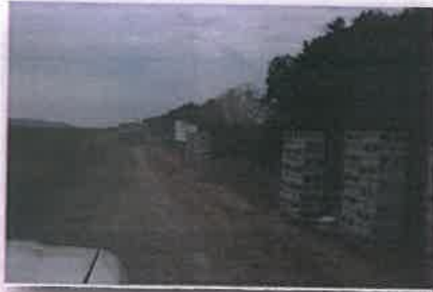
Construcción de cerco perimetral
