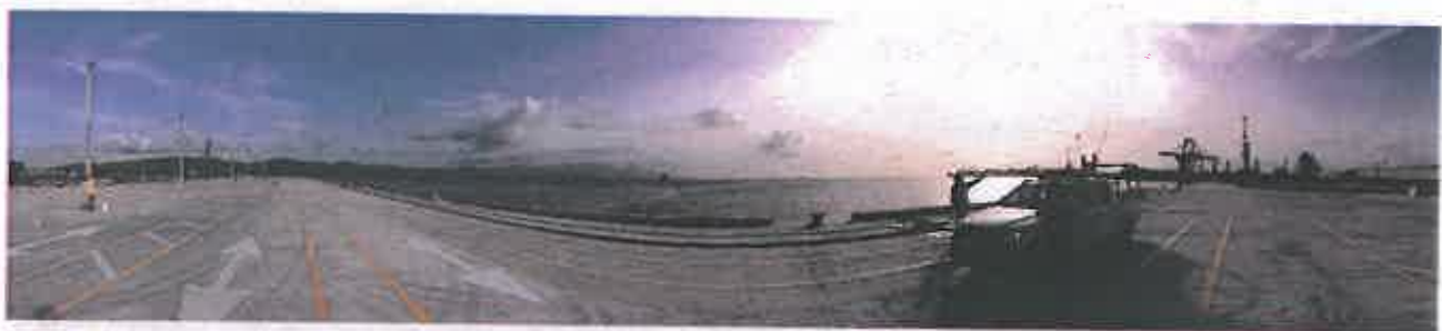
Vista panorámica del Muelle No. 6 terminado en Julio 2018
