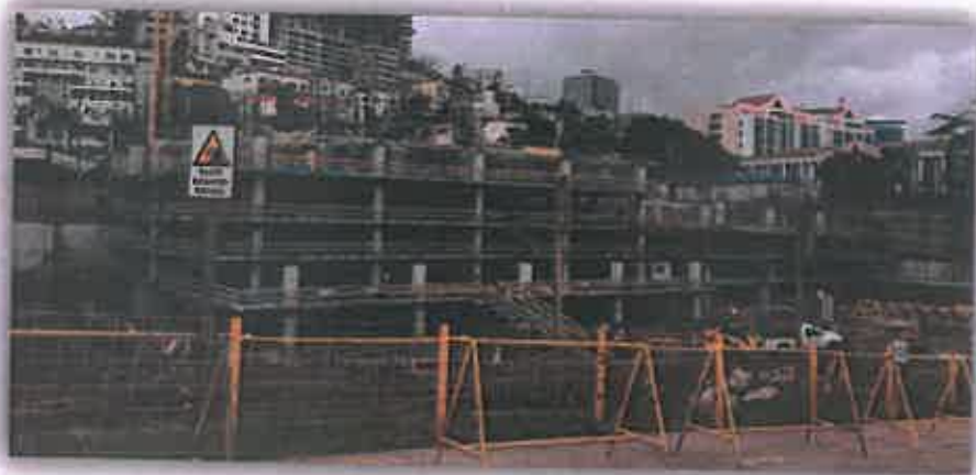
Avance de Obras en Torre 01.
