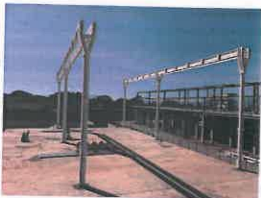
Avance en la estructura del área de recogida de equipajes
