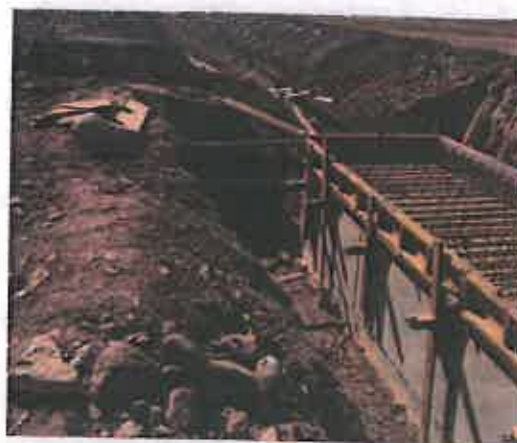
Caja Puente del drenaje de la Plataforma de Aeronaves
