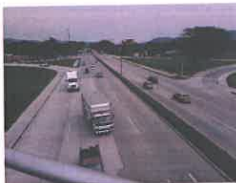
Intercambio en la Intersección con el 2do Anillo (Intercambio Gala)
