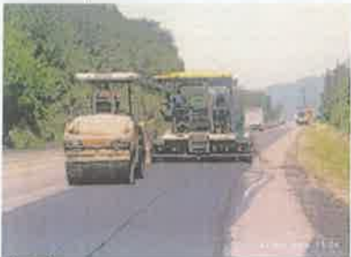
Foto 4. Taulabé – Desvió Santa Cruz de Yojoa Colocación y compactación de capa de mezcla asfáltica en caliente.
