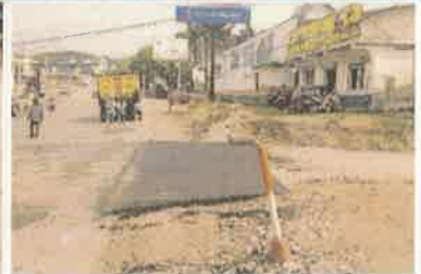
Foto 3. Vista de la colocación de mezcla asfáltica, área de acceso vehicular.
