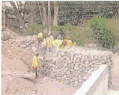
Foto 1. Vista de la Construcción de Muro de Gaviones, aguas abajo, lado derecho
