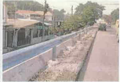
Foto 6. Instalación de Barrera de protección tipo Flexbeam.
