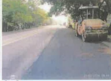
Foto 5. Taulabé – Desvió Santa Cruz de Yojoa Colocación y compactación franja de mezcla asfáltica, espesor 5 cm.
