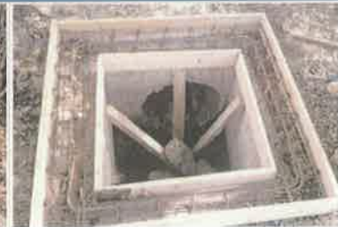
Foto 3. Vista de la colocación de acero de refuerzo, casquete de caja de registro.
