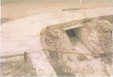
Foto 4. Vista de la construcción de acera peatonal.
