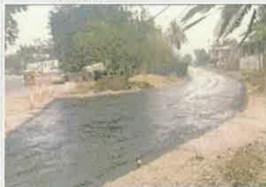
Foto 8. Imprimación de base granular
