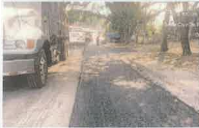
Foto 1. Colocación de mezcla asfáltica en sitio de acceso y parada de buses.
