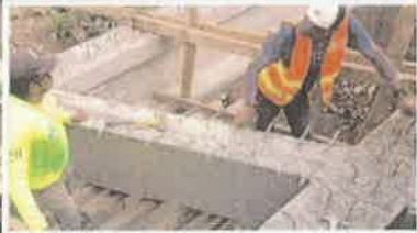
Foto 3. Diafragma construido entre vigas.
