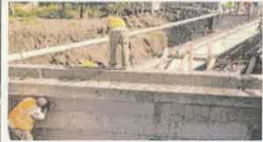
Foto 3. Trabajos realizados sobre el Puente.
