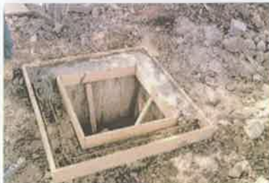
Foto 4. Fundición parte superior de caja de registro.
