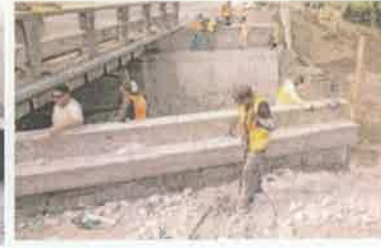
Foto 6. Vista de la obra construida en el periodo.
