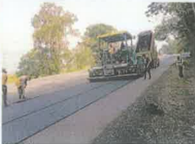
Foto 5. Taulabé – Desvió Santa Cruz de Yojoa Colocación franja de mezcla asfáltica, espesor 5 cm.
