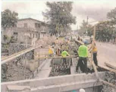
Foto 1. Construcción de diafragmas entre vigas pretensadas.
