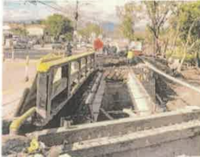
Foto 1. Vista de las vigas pretensadas colocadas, lado izquierdo
