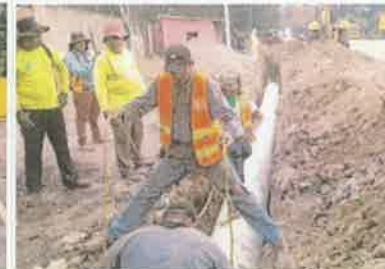
Foto 6. Vista de los trabajos realizados en el sitio.
