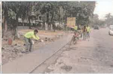
Foto 2. Fundición con concreto hidráulico, sección de acera peatonal, e: 10 cm
