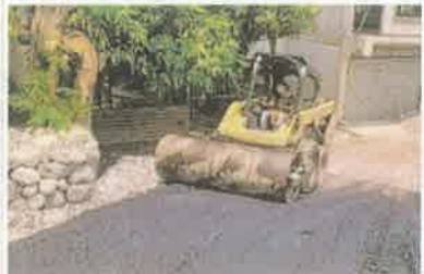
Foto 5. Compactación mezcla asfáltica colocada, extremo de entrada de muro
