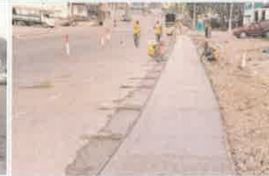
Foto 3. Vista de la construcción de acera peatonal.
