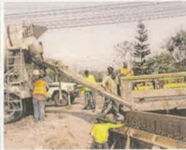
Foto 2. Actividades de fundición con concreto hidráulico
