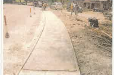
Foto 3. Vista de la construcción de acera peatonal.
