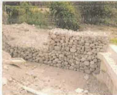
Foto 2. Vista de la Construcción de Muro de Gaviones, estribo 2.
