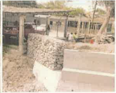
Foto 3. Vista de la Construcción de Muro de Gaviones, estribo 1
