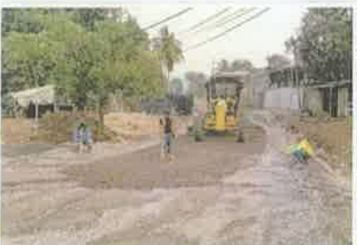
Foto 7. Mezclado de base granular en calle colindante al proyecto.
