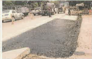
Foto 2. Imprimación área de acceso vehicular.
