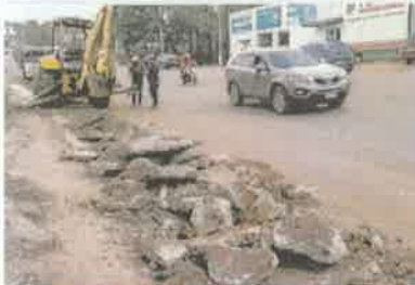
Foto 7. Demolición losas de concreto existentes frente a ferretería FEFASA.
