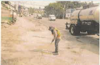
Foto 1. Limpieza de área acceso vehicular, retiro de material suelto en la superficie.
