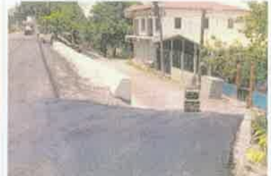
Foto 6. Acceso vehicular con asfalto extremo de salida del muro.
