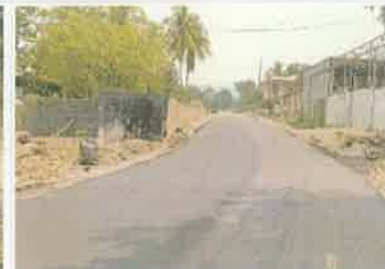
Foto 9. Vista de la carpeta asfáltica colocada en calle colindante.
