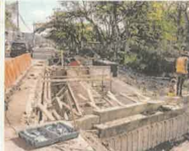
Foto 2. Vista de las obras ejecutadas en el sitio.
