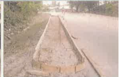
Foto 3. Encofrado sección de acera peatonal y bordillo.
