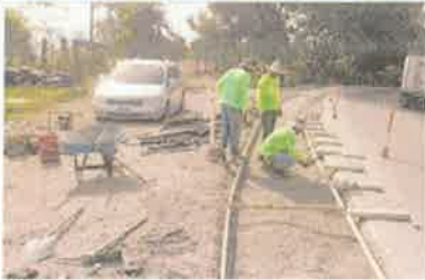
Foto 1. Preparación de área para construcción de acera peatonal
