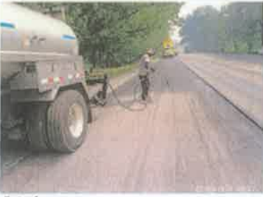
Foto 4. Taulabé – Desvió Santa Cruz de Yojoa Riego de Liga sobre superficie.
