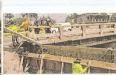
Foto 3. Actividades de fundición con concreto hidráulico
