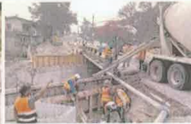
Foto 5. Actividades de fundición con concreto hidráulico.
