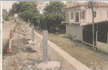
Foto 2. Vista de la colocación de postes metálicos contiguo a corona de muro construido
