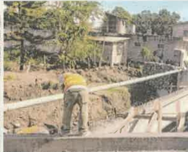
Foto 2. Reubicación de tubería metálica en el Puente.
