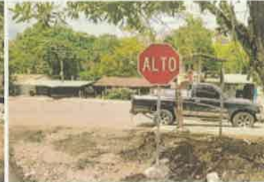
Foto 9. Colocación de señales en varios sitios del proyecto (señal preventiva)
