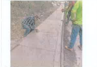
Foto 6. Acabados finales y corte de juntas sobre superficie de acera peatonal.
