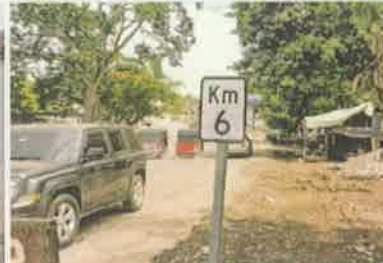
Foto 8. Colocación de señales en varios sitios del proyecto (señal de kilometraje)
