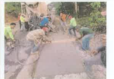
Foto 5. Fundición con concreto hidráulico acera peatonal y bordillo incorporado.
