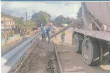
Foto 1. Fundición con concreto hidráulico de acera peatonal.
