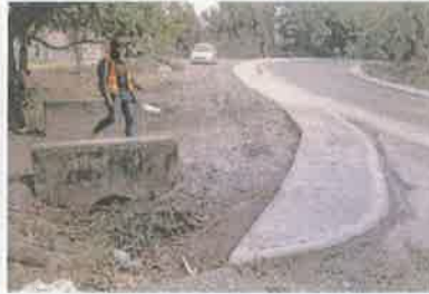
Foto 5. Vista de la construcción de acera peatonal.
