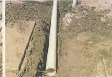
Foto 6. Colocación de tubería de PVC de 6 pulgadas.
