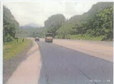
Foto 6. Taulabé – Desvió Santa Cruz de Yojoa Colocación y compactación franja de mezcla asfáltica, espesor 5 cm.
