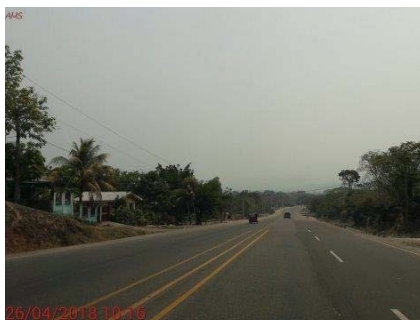
Estado actual de la calzada existente y las ampliaciones. En este tramo prácticamente hasta Santa Rita (km10) está ampliada y pavimentada a 4 carriles.
