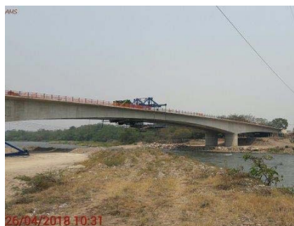
Vista panorámica del estado actual del Puente Santa Rita. En el lado derecha las dovelas están concluidas 12/12
