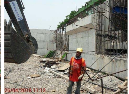
Retro excavadora tirando de los cables a través de los ductos.
