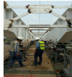
Así se ve el puente La Democracia en este momento, con solo la mitad de las vigas lanzadas. La interrupción del proceso de lanzamiento está ocasionando al puente esfuerzos de torsión de posiblemente perjudiciales debidos a las cargas asimétricas que provocan las vigas colocadas.
