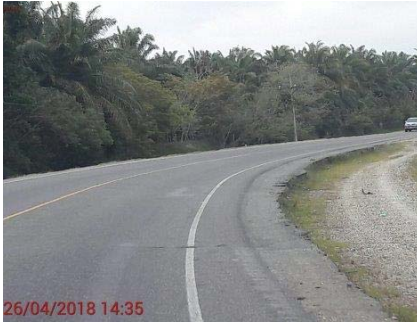
Grada o desnivel peligroso en el hombro de la carretera
