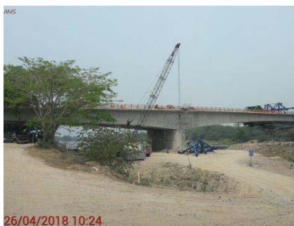
Vista panorámica del estado actual del Puente Santa Rita. En el lado derecha las dovelas están concluidas 12/12
