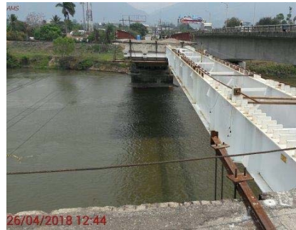
Así se ve el puente La Democracia en este momento, con solo la mitad de las vigas lanzadas. La interrupción del proceso de lanzamiento está ocasionando al puente esfuerzos de torsión de posiblemente perjudiciales debidos a las cargas asimétricas que provocan las vigas colocadas.
