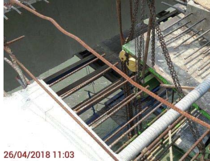
Ultima dovela por ser fundida en el puente Santa Rita, lado izquierdo.
