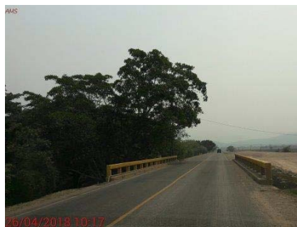
Estado actual de la calzada existente y las ampliaciones. En este tramo prácticamente hasta Santa Rita (km10) está ampliada y pavimentada a 4 carriles.
