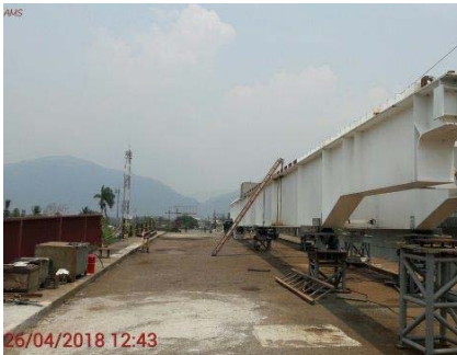
Así se ve el puente La Democracia en este momento, con solo la mitad de las vigas lanzadas. La interrupción del proceso de lanzamiento está ocasionando al puente esfuerzos de torsión de posiblemente perjudiciales debidos a las cargas asimétricas que provocan las vigas colocadas.
