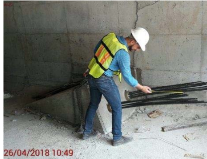
Vista de los cables que fueron recién tensados.
