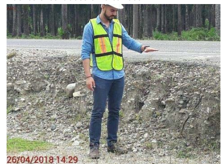
Grada dejada en los trabajos de ampliación de aprox. 1.2m sin señalización, representa un peligro para el conductor.
