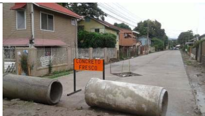
Vista de los trabajos actuales ejecutados por el Consorcio Milenio en la Calle A7.
