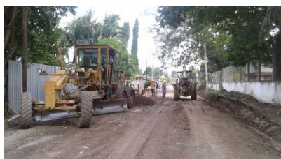
Vista de los trabajos actuales ejecutados por el Consorcio Milenio en la Calle A6.
