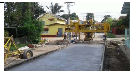
Pavimentación de la calle A7.
