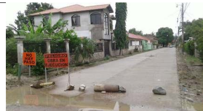
Vista de los trabajos actuales ejecutados por el Consorcio Milenio en la Calle A7.
