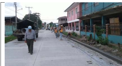
Vista de los trabajos actuales ejecutados por el Consorcio Milenio en la Calle A9.
