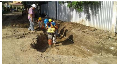
Saneamiento de zona inestable en Calle A6.
